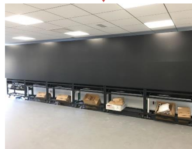
Montaje del nuevo Centro de Control del Puerto
